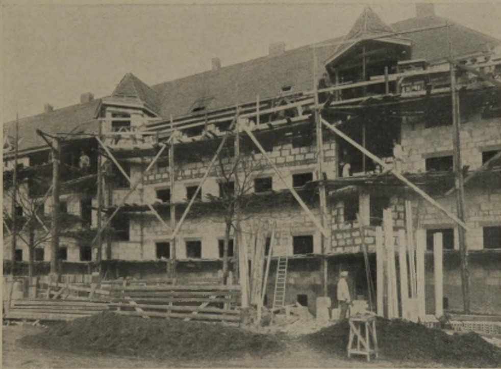
Abb. 5. Dreigeschossige Wohnhausgruppe in Leipzig-Leutzsch, erb. v. d. Stadt Leipzig. Umfassungs-wände, Brandmauern und Scheidewände in Zellenbeton.
