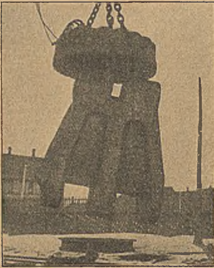
Abbildung 2. Transport eines 1700 kg schweren Gußstückes mit Hilfe eines Magnetkrans.
