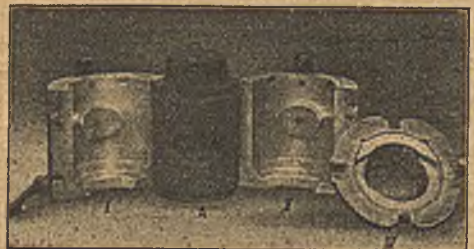
Abbildung 3. Mittelkern mit Kernbüchsen.
