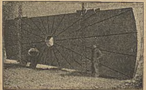
Abbildung 8. Drehtischmittelstück einer 10 363-mm-Karusseldrehbank (Oberansicht).
