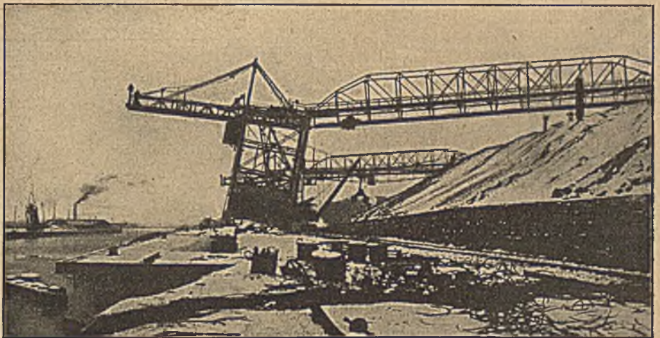
Abbildung 3. Verschiebung einer Verladeeinrichtung in Amerika.
