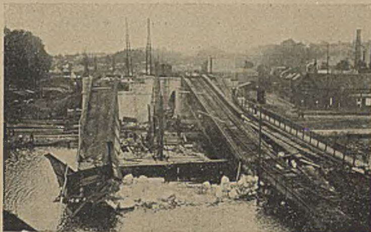
Abbildung 4. Blick auf die Baustelle der Eisenbahnbrücke in Namur. (I. Gleis.)
