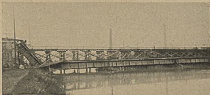
Abbildung 6. Notbrücke in Lumes.
