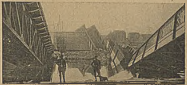
Abbildung 2. Zerstörte Eisenbahnbrücken in Namur.
