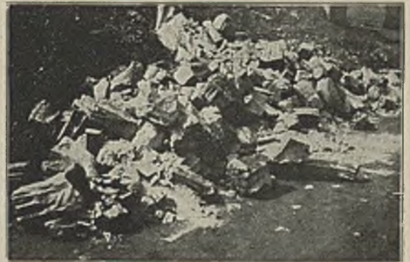
Abbildung 7. Schlackenblock (Rombach), im Kern zerrieselt, dann in sich zusammengestürzt.
