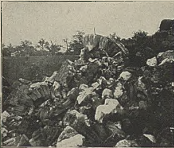
Abbildung 6. Feste Schlacke (Rombach), Absonderung wie Basalt.
