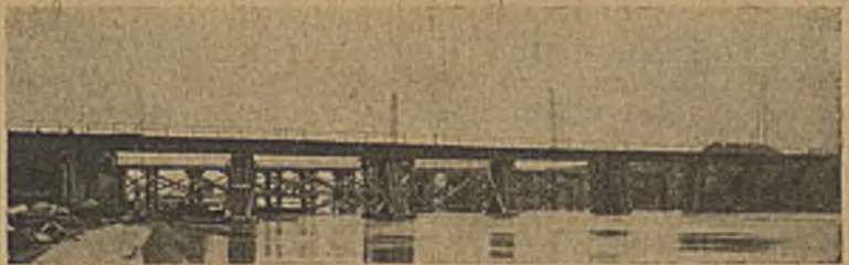
Abbildung 9. Eisenbahnbrücke in Mohon.
