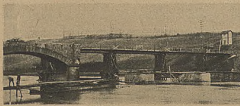
Abbildung 10. Zerstörte Eisenbahnbrücke und Notbrücke in Charleville.
