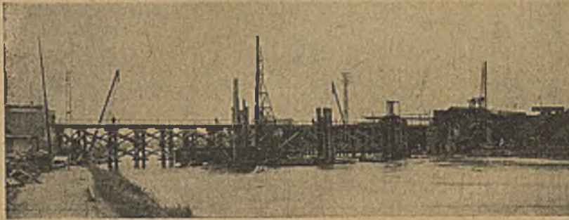
Abbildung 8. Baustelle in Mohon.
