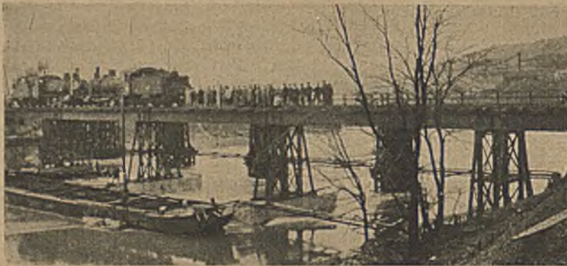
Abbildung 11. Eisenbahnbrücke in Charleville.
