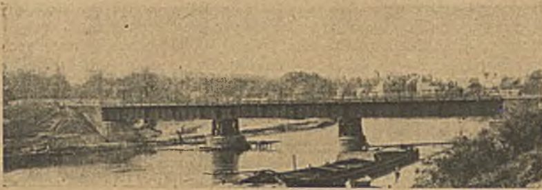
Abbildung 19. Zweigleisige Eisenbahnbrücke in Charleville.
