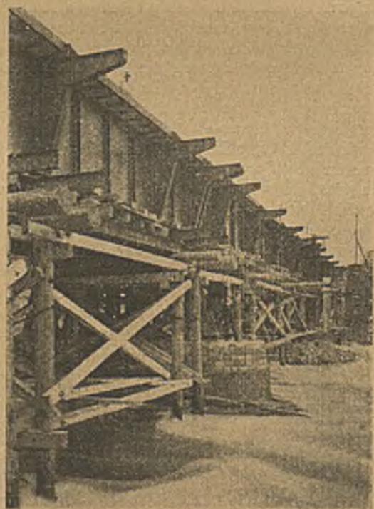
Abbildung 18. Zweigleisige Eisenbahnbrücke in Charleville im Bau.
