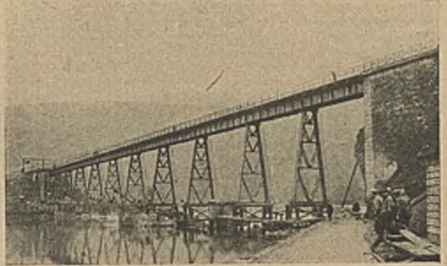
Abbildung 23. Eingleisige Eisenbahnbrücke in Anchamps.
