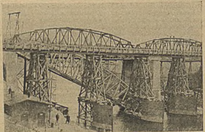
Abbildung 39. Eisenbahnbrücke bei Friedland.
