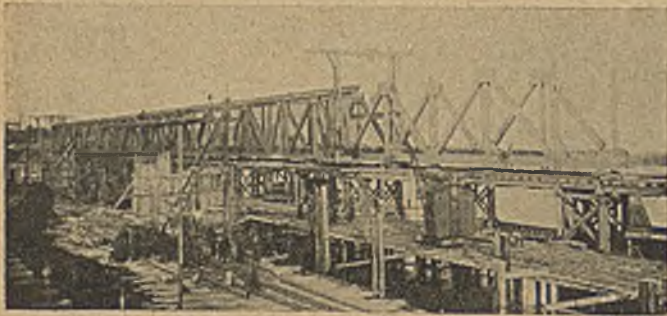
Abbildung 48. Aufstellen der Straßenbrücke Modlin.
