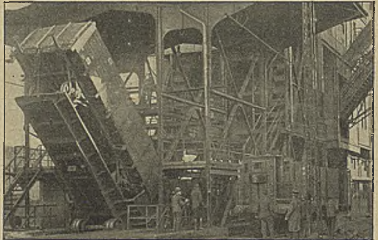
Abb. 1. Wagenkipper und Kohlenmischanlage.
