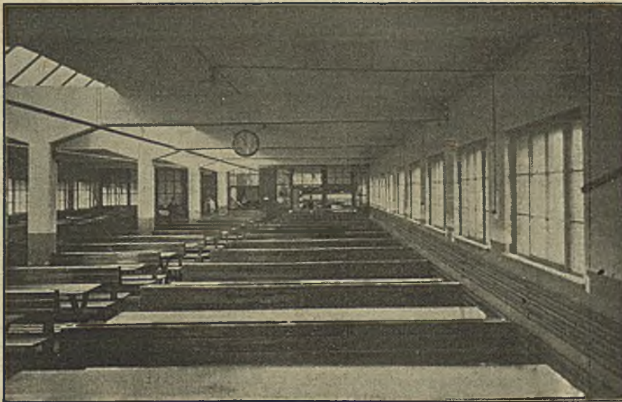
Abbildung 22. Blick in den Speisesaal mit Küche und Kantine.
