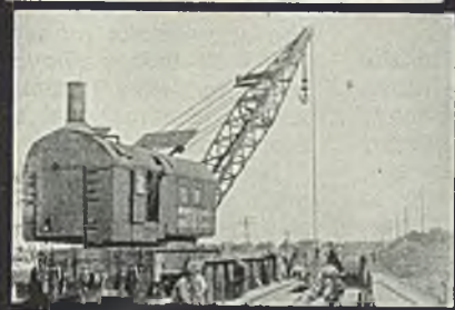
75 TON ERECTION CRANE
