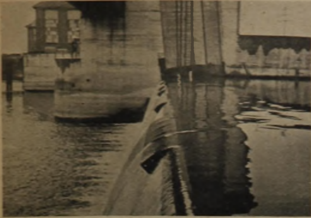
Abb. 11: Auf Grund von Versuchen ermittelte Vorrichtung zur Verhinderung von Wehrschwingungen ohne Aufbauten auf die Klappe und ohne Abflußstörung (Zahnrandklappe der Dortmunder Union an der Wehranlage Dörverden, Weser).
