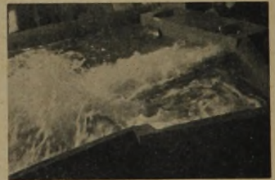
Abb. 4: Ausfluß von 70 m 3 /s aus einem Grundabfluß der Hohenwarde-Sperre. Ursprüngliche Anordnung.
