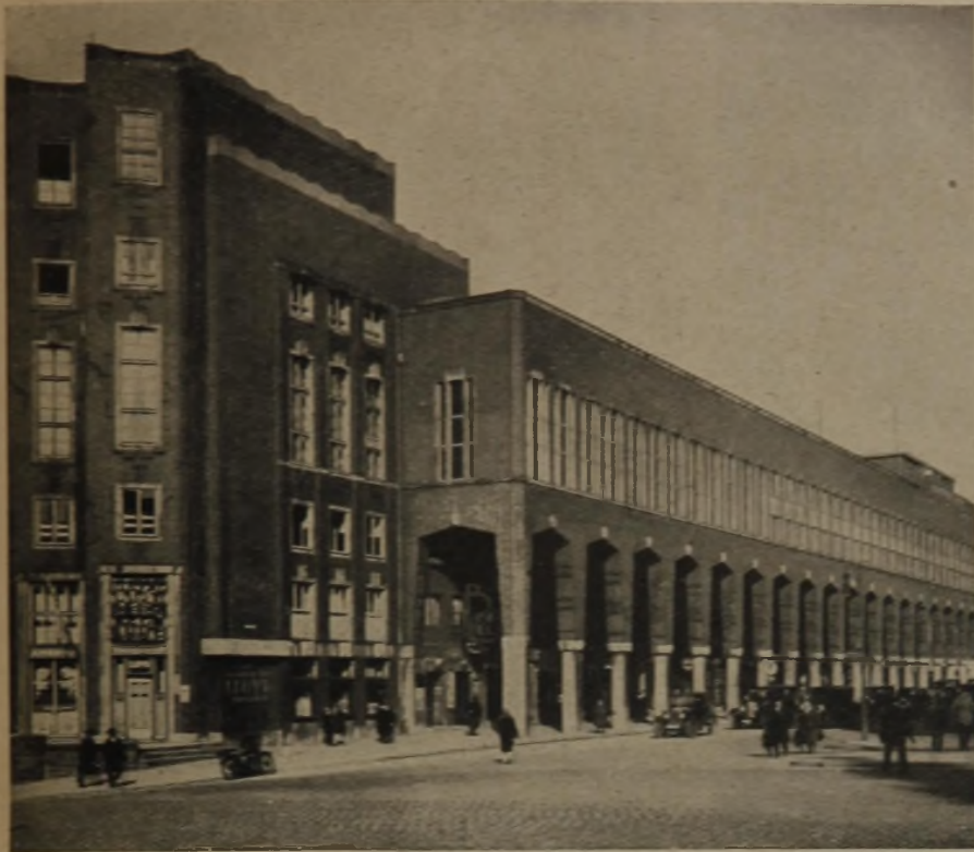
Abb. 1: Ansicht des Hauses der Technik von Westen
