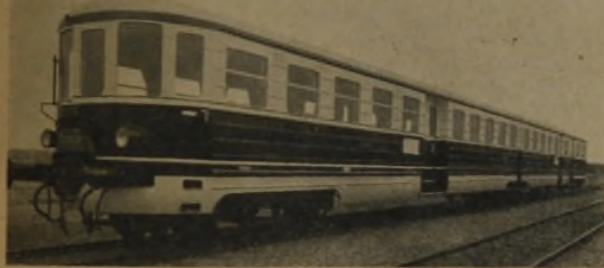
Abb. 29: Dieselelektrischer Triebwagenzug der Weimar-Berka-Blankenhainer Eisenbahn, Konstruktion Dr.-Ing. Croseck DRP. 627 722 Werkfoto: Düsseldorfer Waggonfabrik
