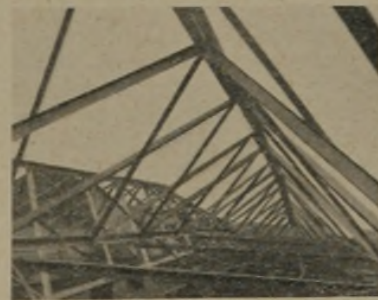
Abb. 16: Binderscheibenpaar einer OLA-Leichtbauhalle mit Satteldach
