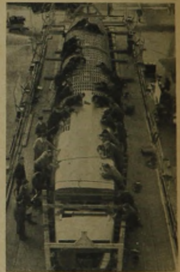
Abb. 26: Schalenrumpf der Junkers Ju 90 im Baugerüst 15) Werkfoto JFM.
