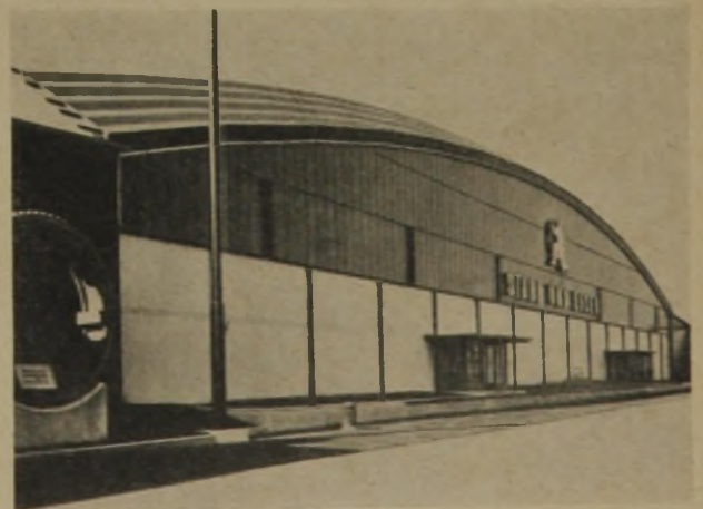
Abb. 7: Hallenkonstruktion, System Hünnebeck
