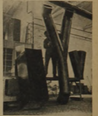
Abb. 30: Hosenrohr aus Mipolam — PCU, geschweißt. Hersteller: Schrupp & Müller, Betzdorf (Sieg)
