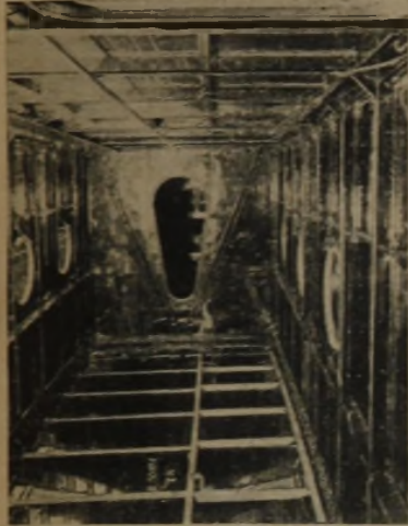
Abb. 18: zeigt das Innere des Rumpfes des Flugbootes Rohrbach „Rocco“ 19)
