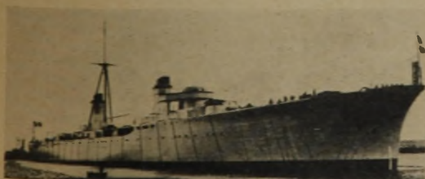
Abb. 7: Gesamtansicht des geschweißten Kreuzers „Emanuele Filiberto“ der Königlich-Italienischen Marine
