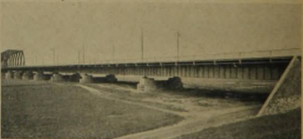
Abb. 6: Vortlufbrücke für die Admiral-Graf-Spee-Rheinbrücke, Gewicht 1000 t, Werkstoff Krupp St 52, elektrisch geschweißt mit Mantelelektroden Zeus EV 52
