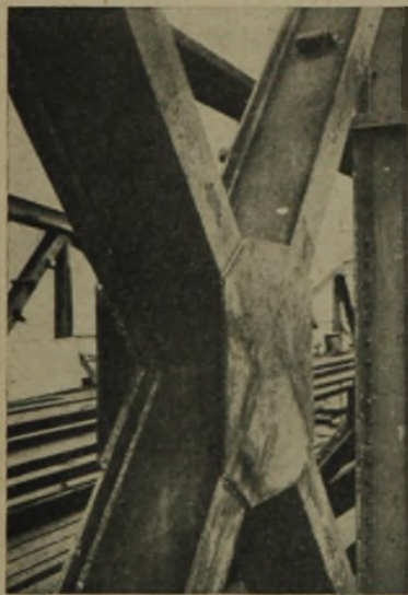
Abb. 8: Elbebrücke bei Dönitz (Kreuzungspunkt von zwei verstärkten Diagonalen)
