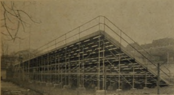
Abb. 5: Torkret-Leichtkonstruktion aus Stahlrohren für die Tribüne Eisstadion Düsseldorf
