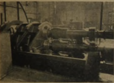
Abb. 19 bis 21: Kammwalzgerüst einer 500er-Straße
