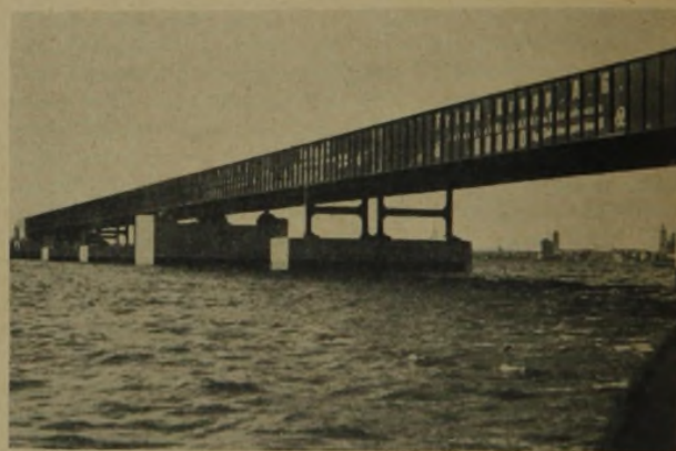
Abb. 5: Straßen- und Eisenbahnbrücke über den Strela-Sund. S 37, geschweißt
