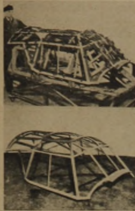
Abb. 16: Kabinenraumüberdachung in Elektron
