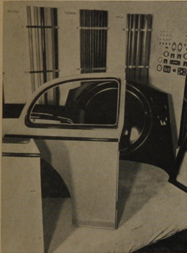
Abb. 5: Karosserieteile aus Preßstoff (Dynamit AG. vorm. Alfred Nobel & Co., Troisdorf)
