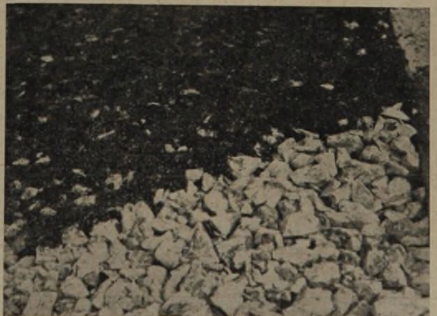
Abb. 5: Teerstreumakadam: In die Schotterdecke eingestreuter Teersplitt
