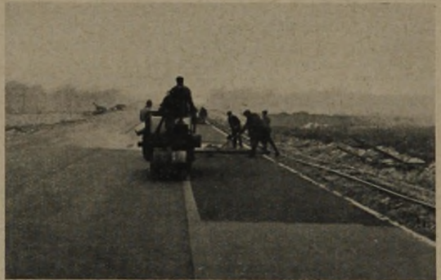
Bild 4: Teermischmakadam auf einem Reichsautobahnzubringer. Einbau der Verschleißschicht
