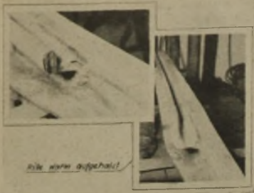
Abb. 16: Fertiggeschweißter Stoß
