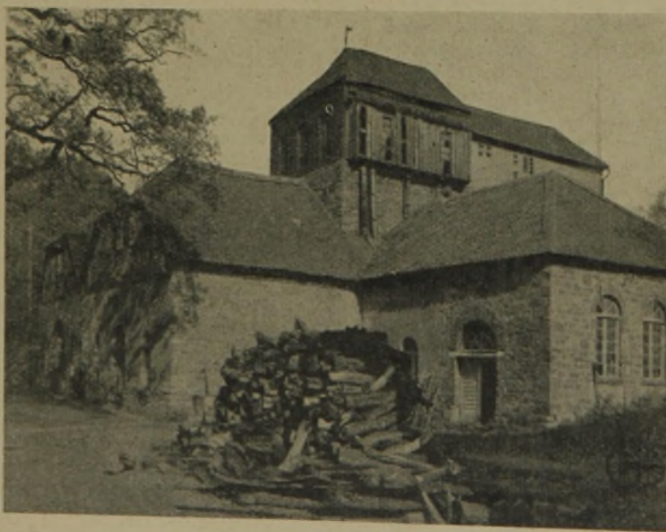
Abb. 1: Die Louisenhütte in Wocklum, Außenansicht. In der Mitte des Bildes der Hoch-ofen, davor links die Gießhalle für Masseln und Gänzel, dahinter ganz links die Gieß-halle für den Feinguß mit den beiden Kupolöfen. Rechts im Bilde der Maschinenraum mit Gebläsekesseln, Wasserrad und Dampfmaschine
