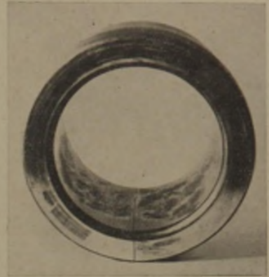
Abb. 14: Reibrost in der Bohrung eines Innenringes
