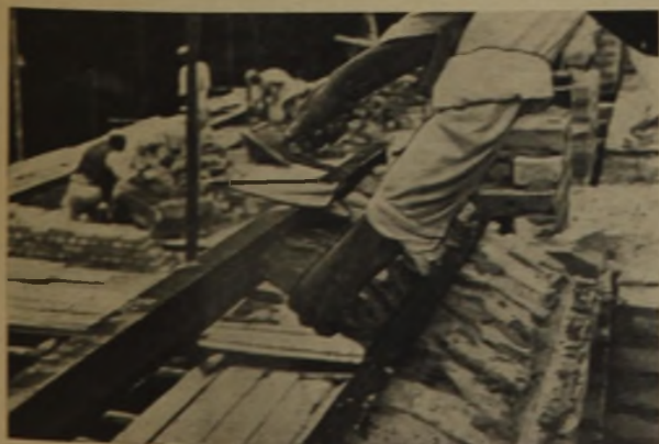
Abb. 11: Schräger Türsturz aus I-Eisen
