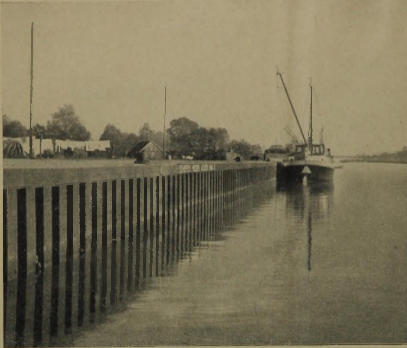
Uferbefestigung mit Spundwandisen
