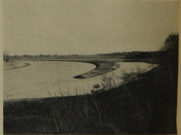
Regulierung der Elbe. Abschwächung einer starken Krümmung
