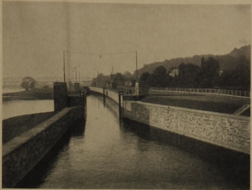
Schleppzugschleuse in der Weser bei Hameln
