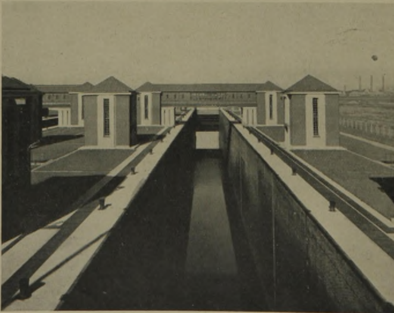
Hindenburgschleuse im Mittellandkanal. Östliche Kammer geleert
