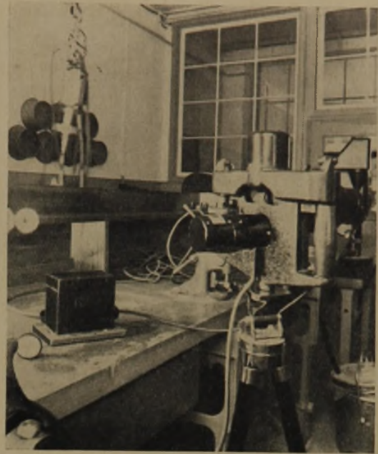
Abb. 10: Die optische Messung der Umlaufzahl mit dem Stroboskop
