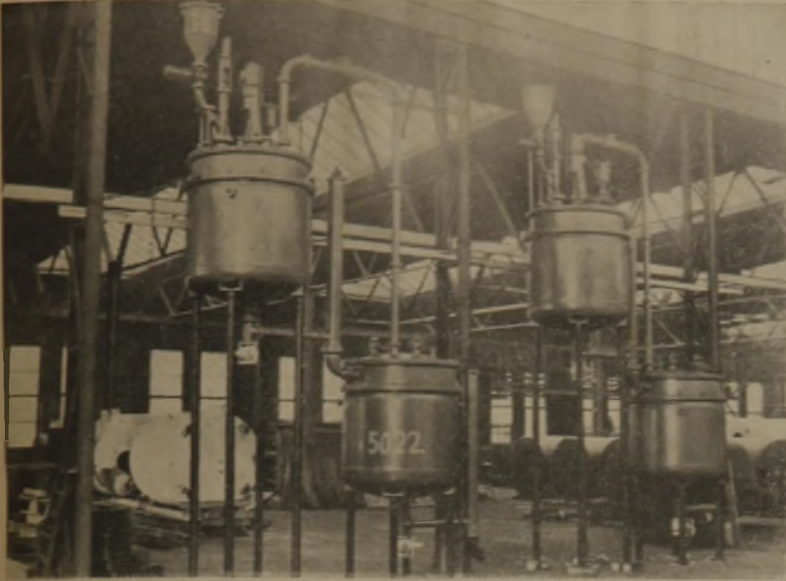
Apparaturen aus glasemailliertem Stahl zur Herstellung von Ammoniumsulfat Werkaufr. Pfaudler-Werke
