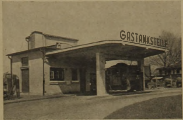
Abb. 7: Ausgebaute und betriebsfertige Gastankstelle
