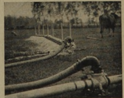
Abb. 2: Maschinelle Abwasserleitung auf einer Weide
