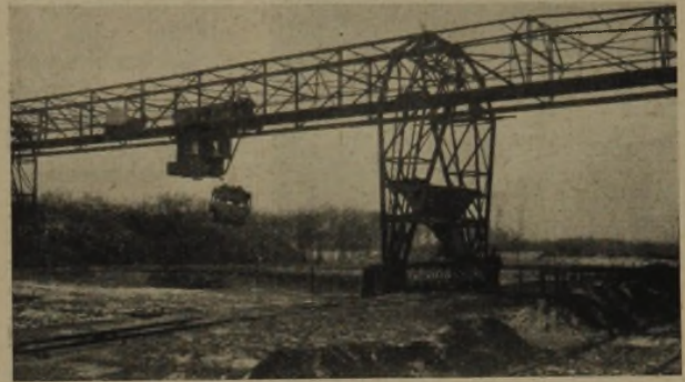
Abb. 11: Kohlenkläranlage mit maschineller Schlammeusräumung
