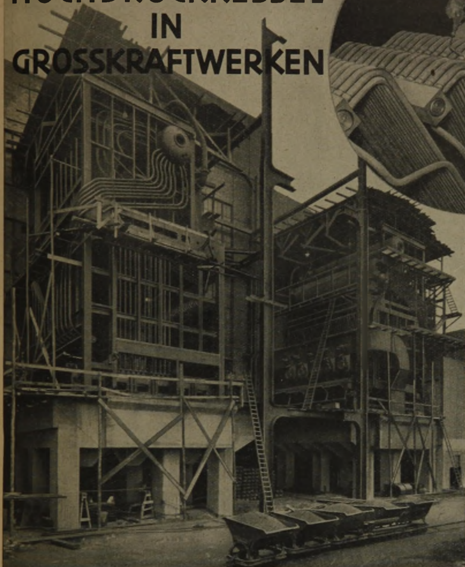
HERSTELLUNG DER ROHR- PAKETE FÜR BENSONKESSEL
