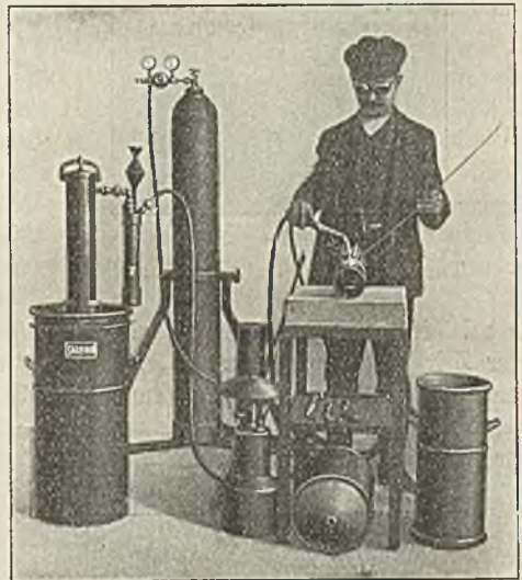
Abbildung 57. Kupferschweißanlage mit Karbididapparat.
