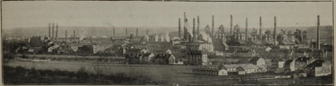
Gesamtansicht des Rombacher Werks von Norden.
