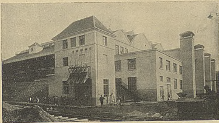
Abbildung 33. Nordwestecke des Gußwerkes mit der Bunkeranlage (links), der Eisenrückgewinnungsanlage (Mitte) und den Gußputzerei-Entstaubungstürmen (rechts).
