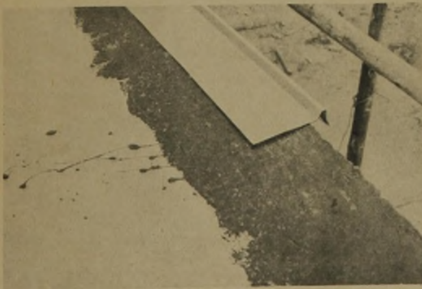
ZINKABSCHLUSSBLECH MIT UNTERSTRICH ZUR ISOLIERUNG DER BLECHE
