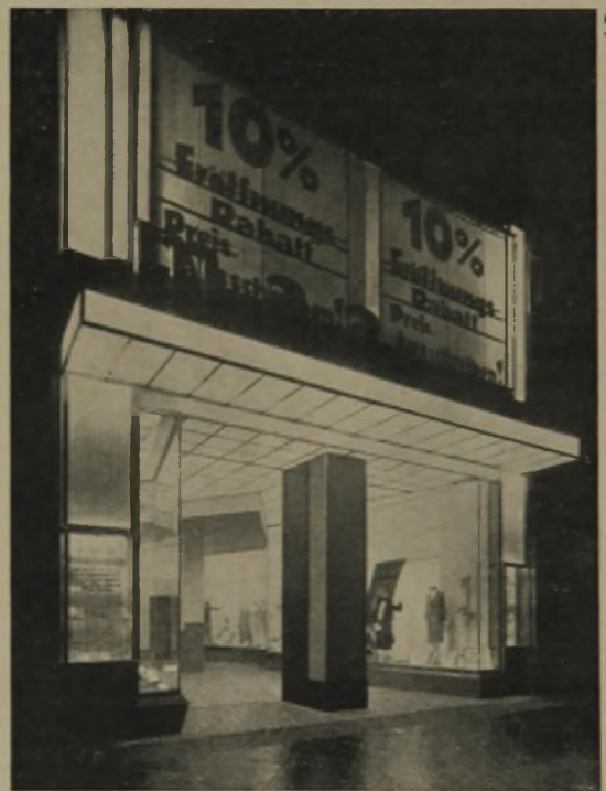
Bei sehr schmaler Straßenfront 32 m Schaufenster. Schaufensterausleuchtung durch Kombination von Tiefstrahlern, Fußleisten und Kleinscheinwerfern verschiedenster Art. Wetterschutz (Überschweller) mit Glühlampenarmierung unter Reflektorrinnen als Leuchtbuchstabenträger
