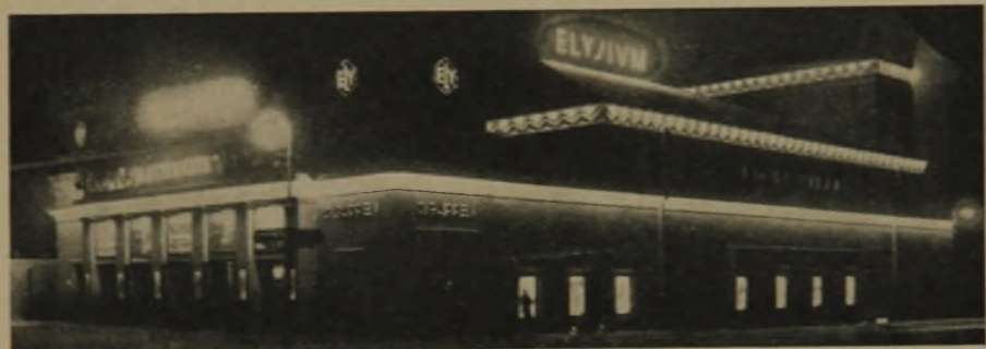
Kombinierte Lichtarchitektur Aus Lichtvoute, Leuchtröhrenkontur, Lichtbuchstaben und durch Flutlicht angestrahlte Plakatflächen. Die Lichtarchitektur betont in der Hauptsache die Baukonturen
