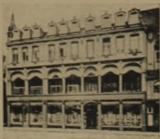
Zu 2 u. 3: Neonröhren, die dem Kaufhaus a. d. 90er Jahren ein modernes, werbestarkes Gepräge geben. Röhrenanlage an sich kostspielig, doch in Stromverbrauch und Unterhaltung betriebsbillig
