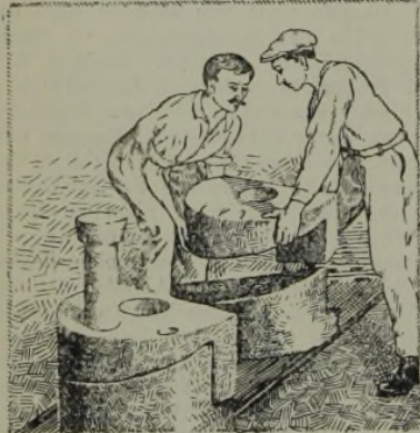
Abbildung 1. Ausschließlich aus Kernen bestehende Form für Manganstahl-Förderwerkflügel.
