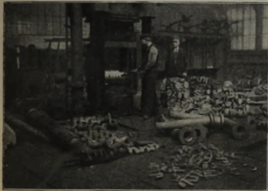
AUS DER KURBELWELLEN- UND ACHSTRICHTERFABRIKATION.
