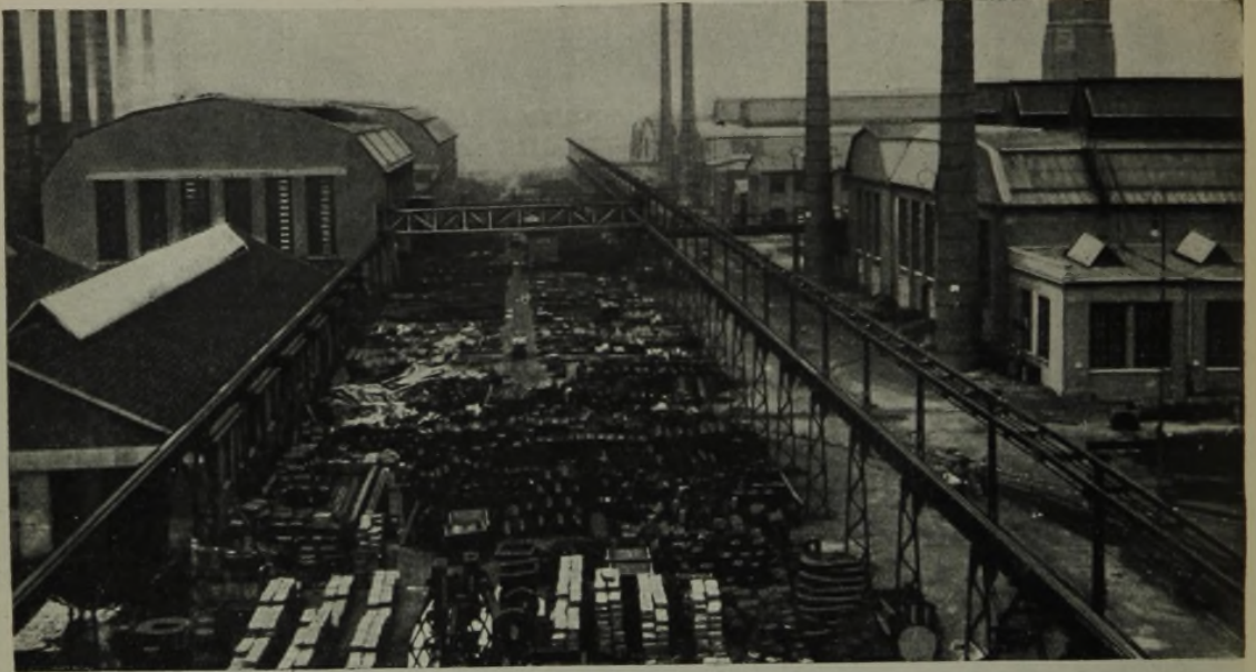
STAHLWERK DÜSSELDORF: BLOCKPLATZ.
