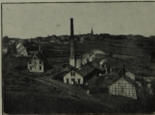
ANSICHT DES ALTEN STAHLWERKES.
