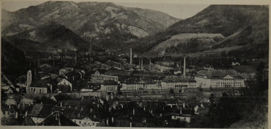
GUSSSTAHLWERK KAPFENBERG: HAUPTANSICHT.
