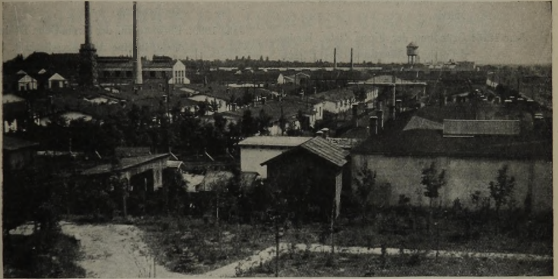
WERKZEUGFABRIK SOLLENAU: ÖSTLICHER TEIL.
