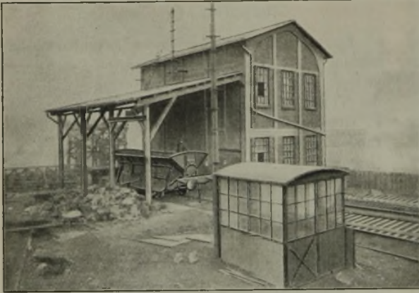
Abbildung 1. Außenansicht: Zufuhr des Rohgutes.
