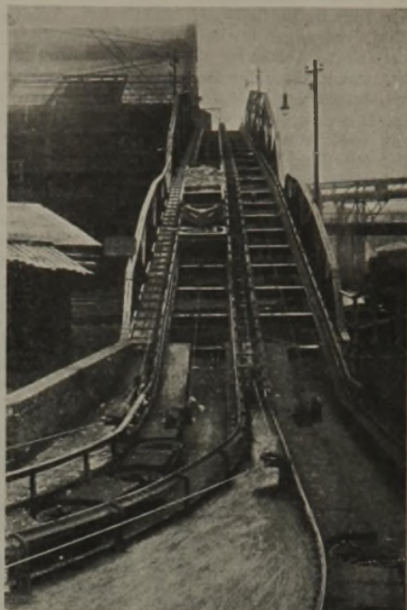
Abbildung 2. Auffahrt des Kalkwagens auf die Konverterbühne.
