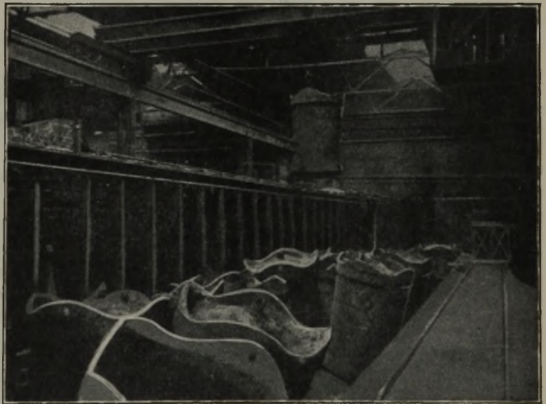
Abbildung 17. Topfglühanlage mit Halbgasfeuerung.
