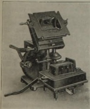
Abbildung 4. Handrüttelmaschine mit Wendplatte.
