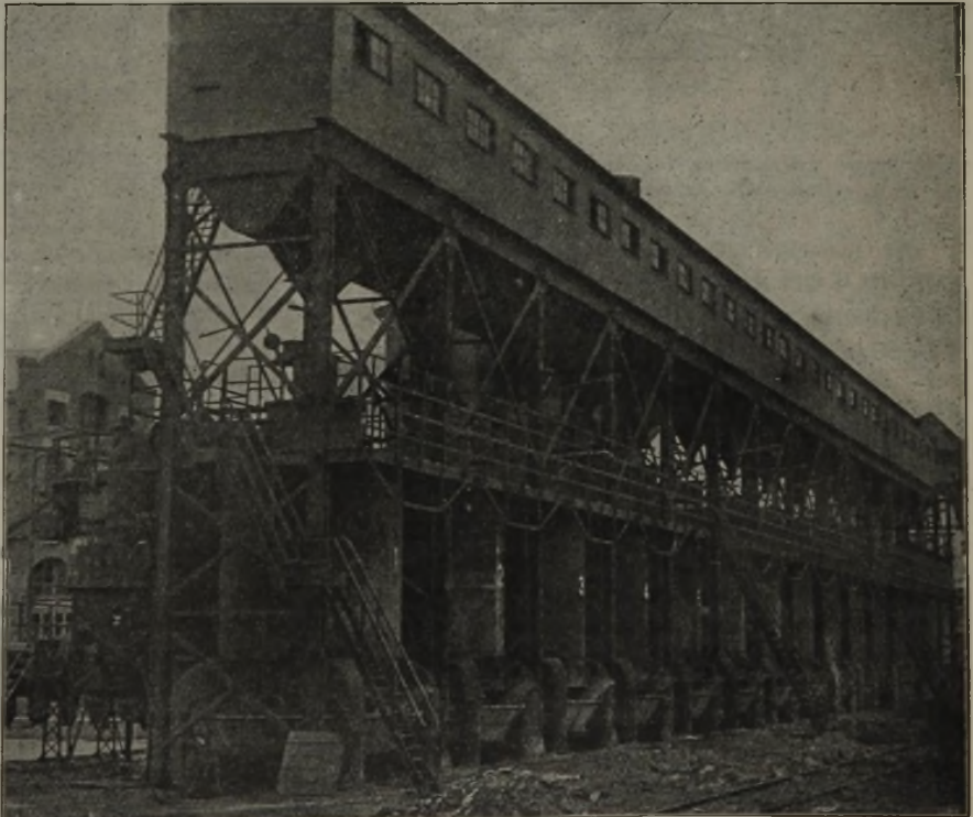
Abbildung 4. Neuere Mondgasanlage in Fuschun.
