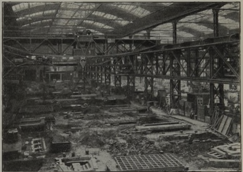
Abbildung 4. Innenansicht der Gießhallen.
