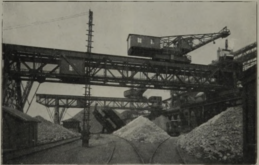
Abbildung 4. Wagenkipper und Erztasche.
