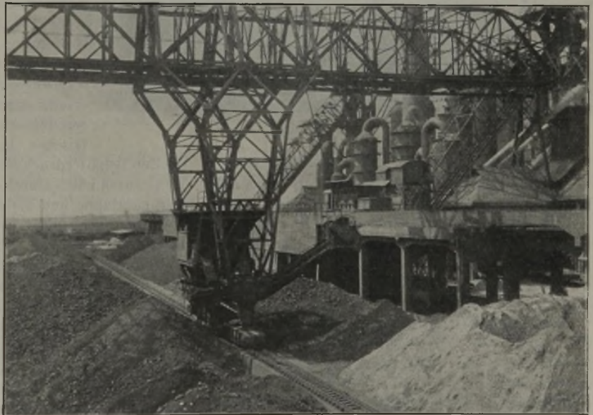
Abbildung 5. Erzbrecher und Bunker.
