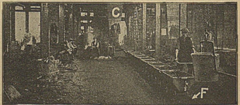
Abbildung 6. Abgießen von 8 Formkästen von der Hängebahn aus.
