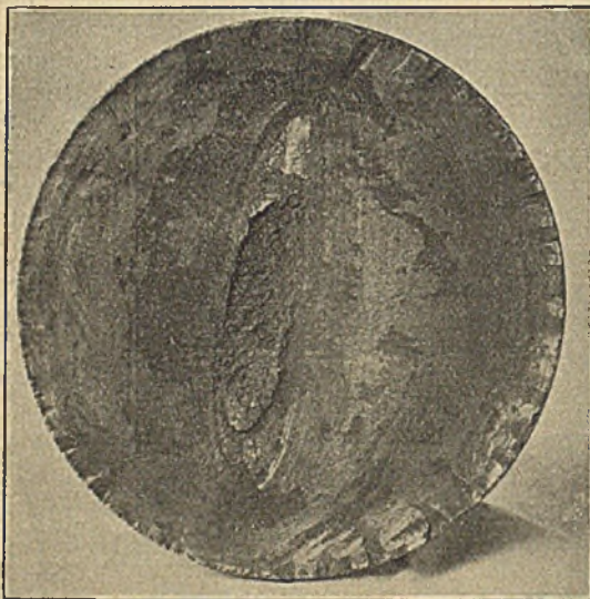
Abbildung 3. Bruch einer Achse eines Straßenbahn-Motorwagens.
