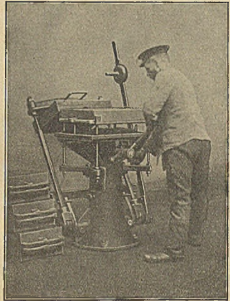
Abbildung 19. Handhebelformmaschine während des Abhebens.
