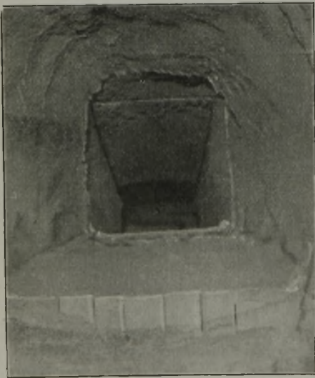
Abbildung 4. Torkretierter Gaszug eines Siemens-Martin-Ofens mit eingesetzter Blechschablone.
