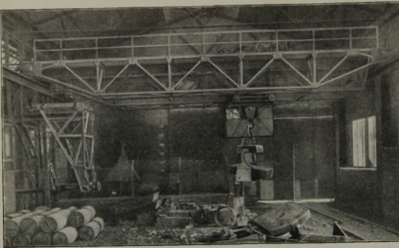
Abbildung 1. Universalkran als Muldentransportkran, links Beschickungsgerüst mit Schwengel auf einem Auflegebock.
