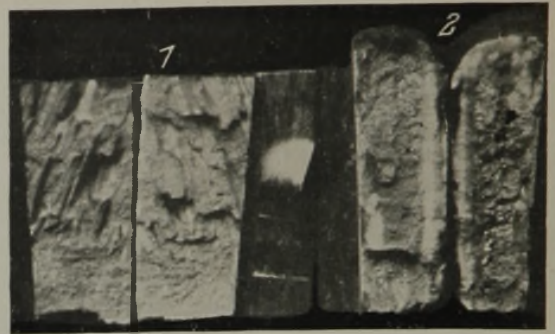
Abbildung 12. Verbesserung des Kaltbruches durch Glühen.
