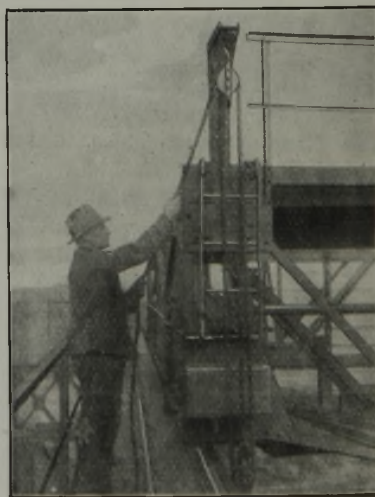
Abbildung 9. Auswechselbare Galgen an einem im Freien laufenden Kran zur Montage der Kranlaufräder.
