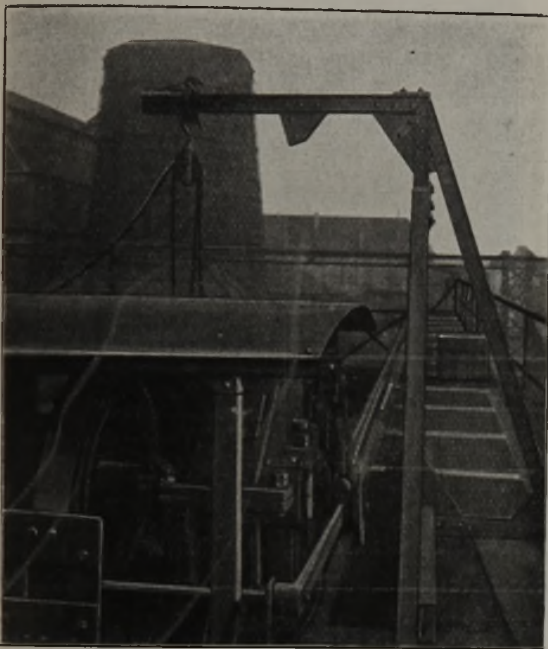
Abbildung 10. Auslegerbock an einem im Freien laufenden Kran zur leichteren Katzendemontage.
