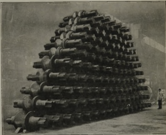
Abbildung 12. 360 t Pilgerschrittwalzen. (Geliefert vom Stahlwerk Krieger, Düsseldorf-Oberkassel.)
